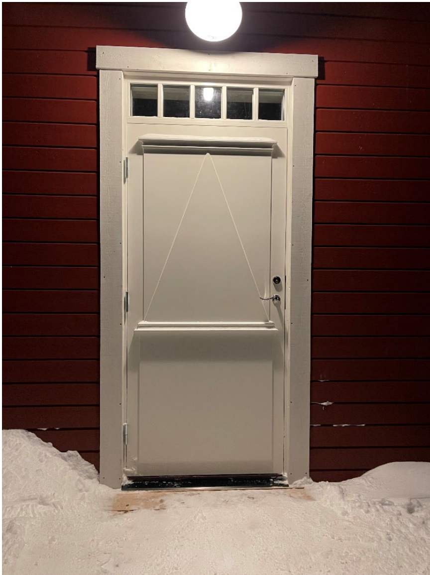
Ytterdörren på plats
